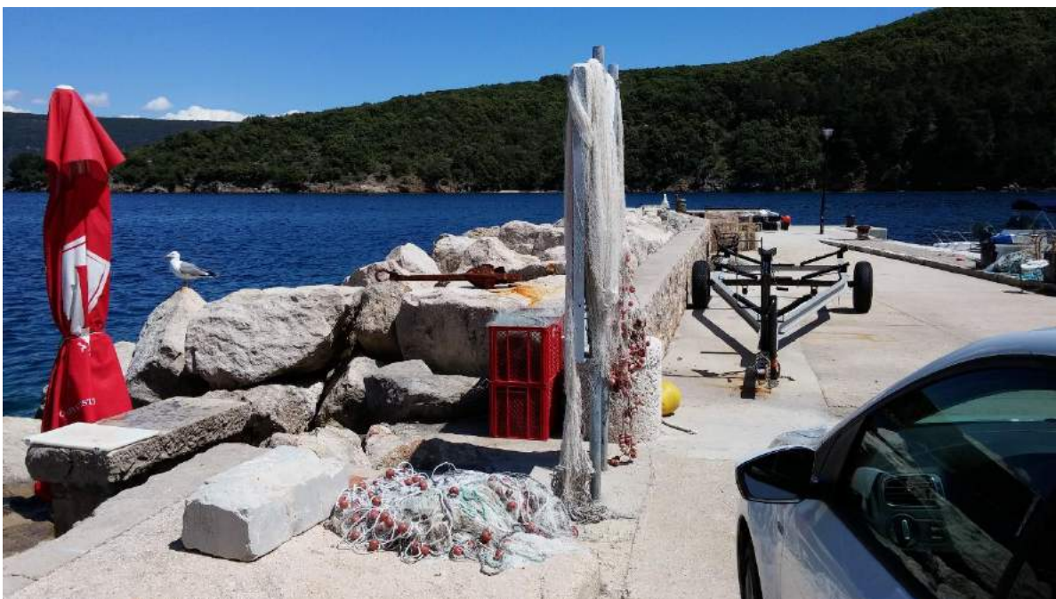
Slika 1: Pogled na izvedeni lukobran
